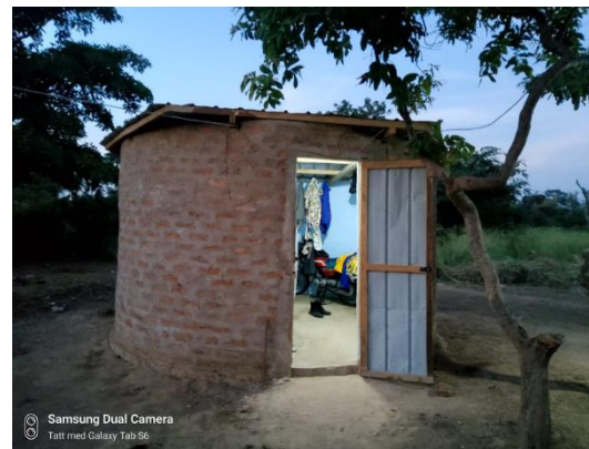
En av flere lærerboliger på skoletomten, finansiert og bygget av lokalbefolkningen.
