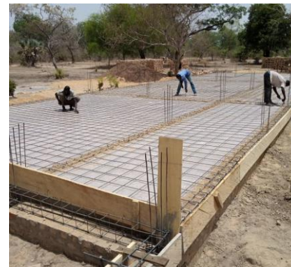
Pose des fers à béton avant coulage du sol.
