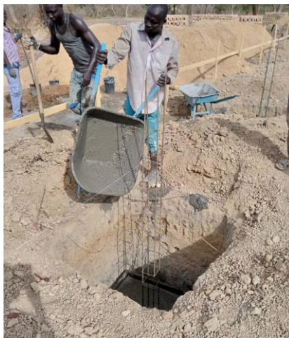
La semelle en béton armé assure une construction stable.
