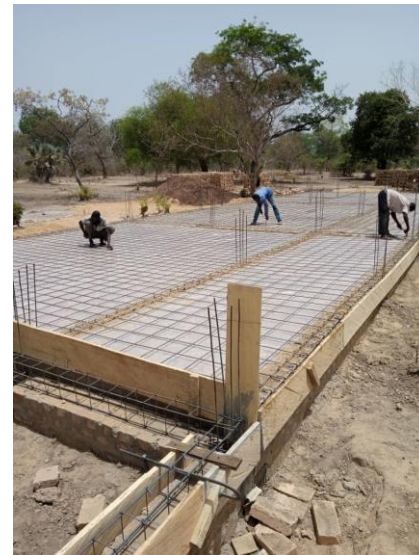
Over: Armering før støping av gulv.
