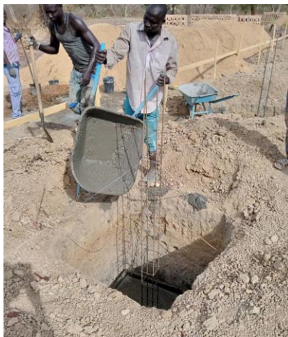
Armert såle av betong sikrer stabilt bygg.
